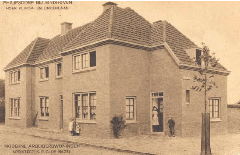
Afbeelding 4: Oude ansichten als deze vormden belangrijk studiemateriaal voor renovatie van Philipsdorp door de BouwhulpGroep. Beeld: RHCE.
