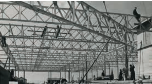
Afbeelding 3.6 De constructie van de perronoverkapping
