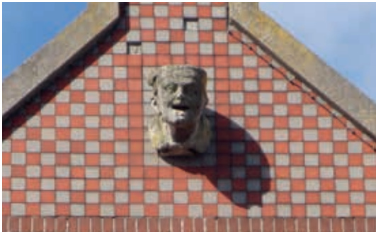
Afbeelding 2.8 Gaper op gevel, hoek Rechtestraat-Catharinaplein, door Toon Brams
