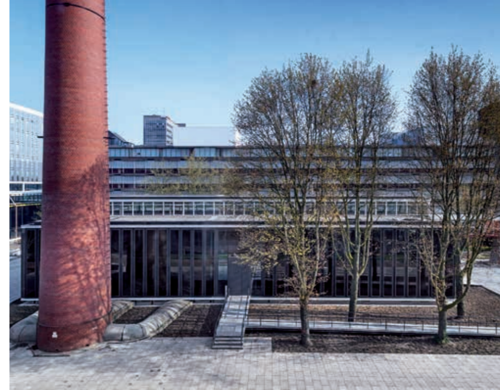
△ Het historische en industriële karakter van Ceres, voormalig ketelgebouw uit 1959, is grotendeels intact gebleven, net als de zeventig meter hoge bakstenen schoorsteen naast het gebouw.
