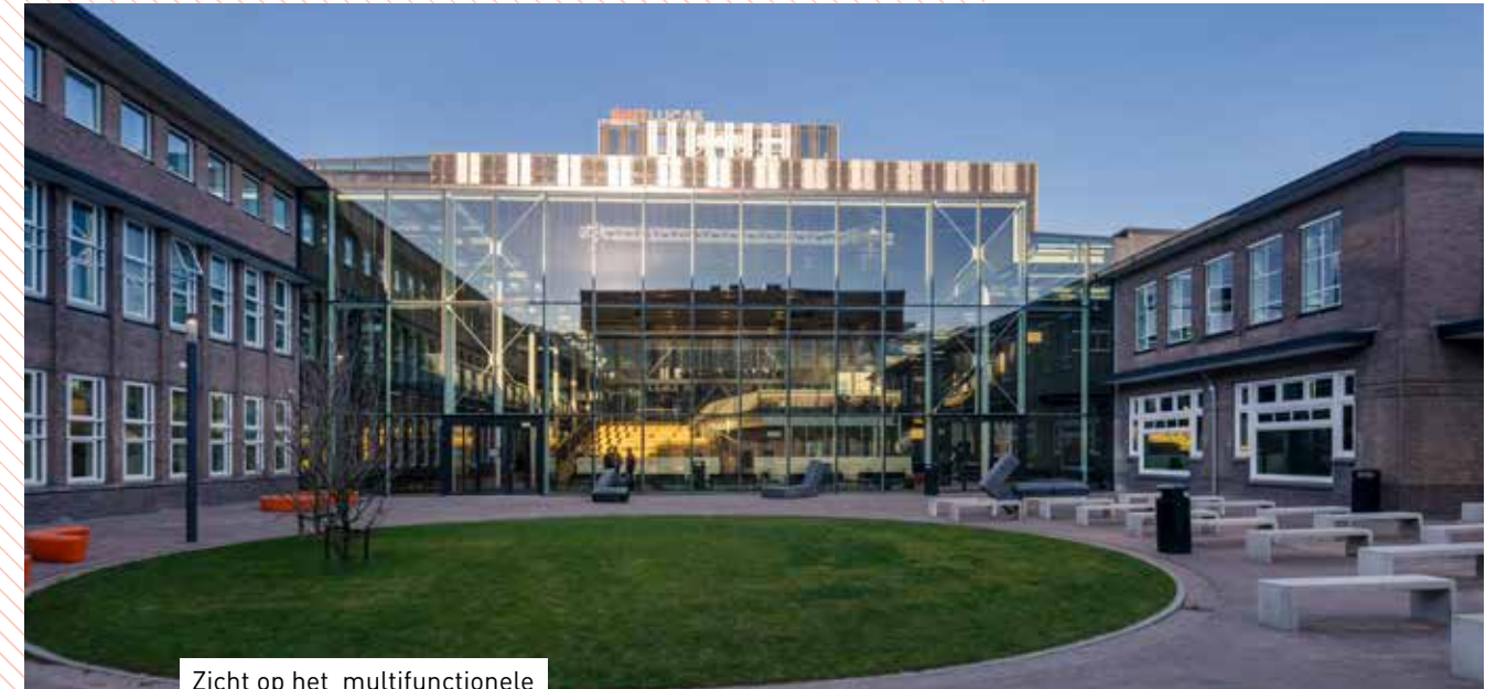
Zicht op het multifunctionele gebouwhart van SintLucas.
